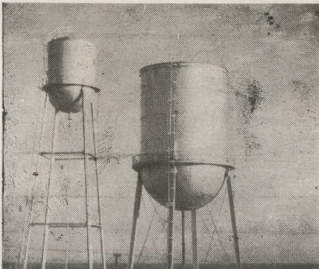
Izquierda: e tanki chikito ta contene un reserva di 50,000 galón di awa dusji pa uso di Hospitaal; e tanki grandi cu un capacidad di 150,000 galon, ta pa awa braak. Derecho: No. 1 Evaporating Plant ta haci awa di lamá (cayente, fo'i e "cooler"-nan na Gas Plant) bira awa dusji pa uso den boilerlan den refinaria.
